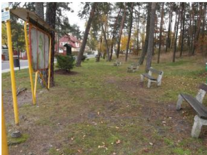
Stávající dožilý mobiliář
